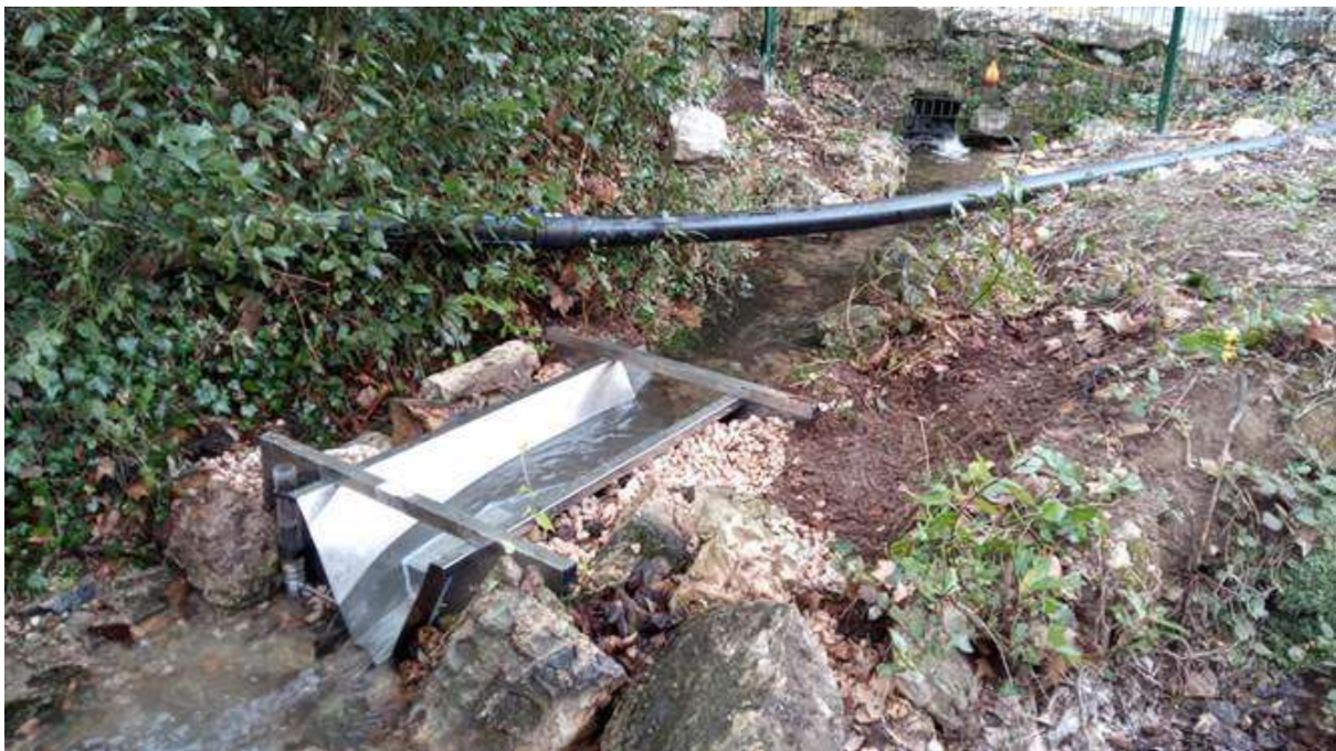
Figure 102. Canal de mesure installé par la CAPV sur l'exutoire de la source pour les essais de pompage de longue durée
